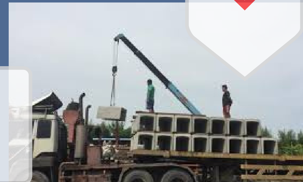
Stockyard & loading Elemen RAPI Curing dan pengelompokan elemen RAPI / unit rumah
