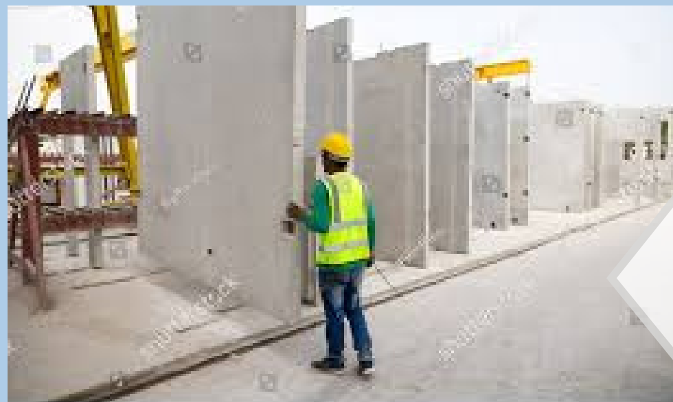
Konstruksi & Supervisi by subkon, sebagai inhouse mandor rekanan
